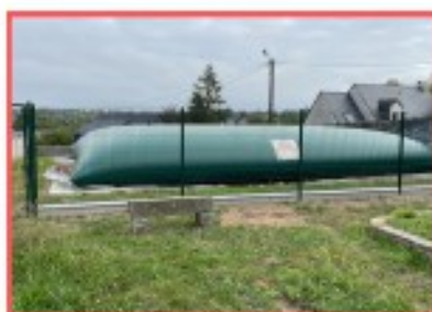
Clôture autour de la réserve incendie
