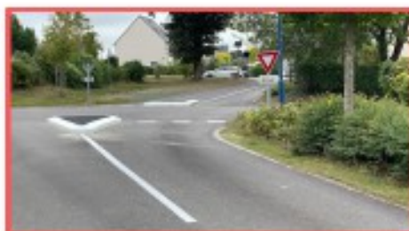
Aménagement du carrefour de Bel Air
