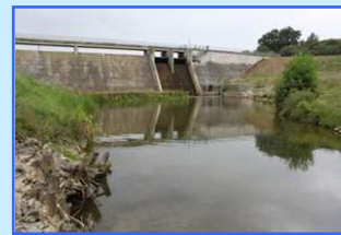
Barrage de la Cantache
