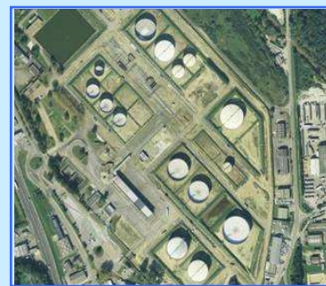
Dépôt pétrolier de Vern sur Seiche
