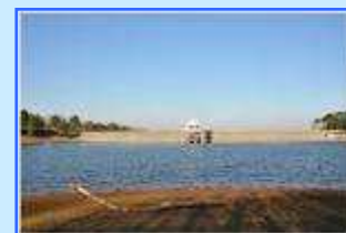
Barrage de la Chèze
